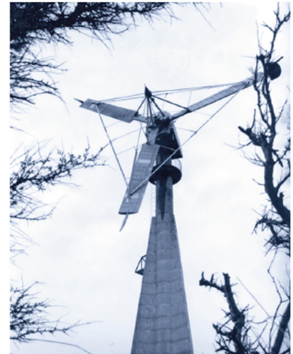
FIGURA 2.33 Turbina eólica de Gedser, Dinamarca. Fonte: The Danish Museum of Energy.
