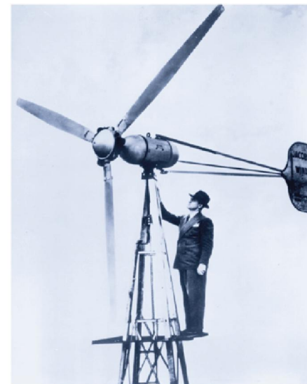
FIGURA 2.41 Turbina eólica de Jacobs. A figura apresenta Marcellus Jacobs ao lado de uma máquina de 2,5 kW nos anos 1940. Fonte: Jacobs Wind.
