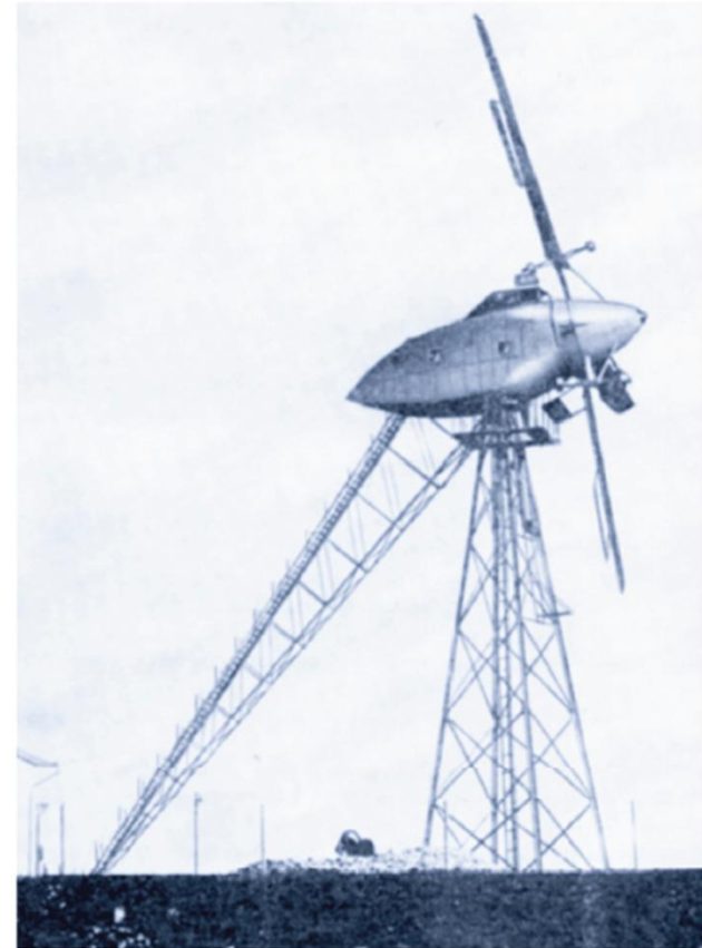
FIGURA 2.44 A turbina eólica russa instalada em Balaklava em 1931.
