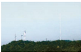
Paisagem do local de instalação
