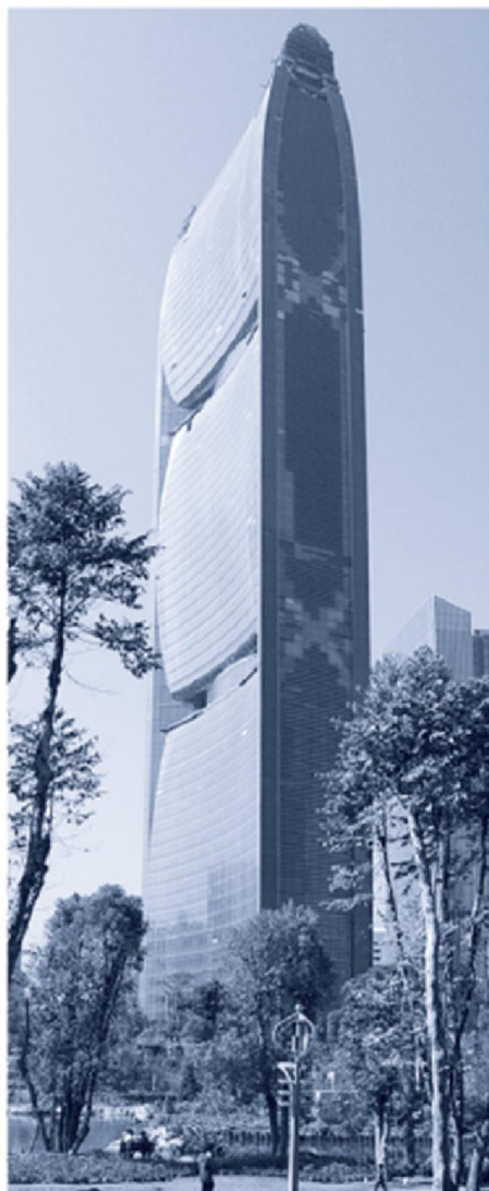
FIGURA 6.43 O Pearl River Tower, na China, inclui duas turbinas eólicas na sua estrutura.
