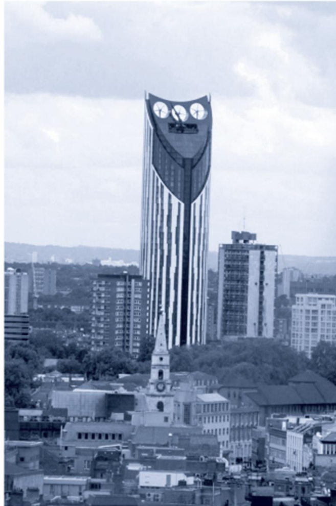
FIGURA 6.45 Edifício Strata SE1, em Londres, com suas três turbinas eólicas.
