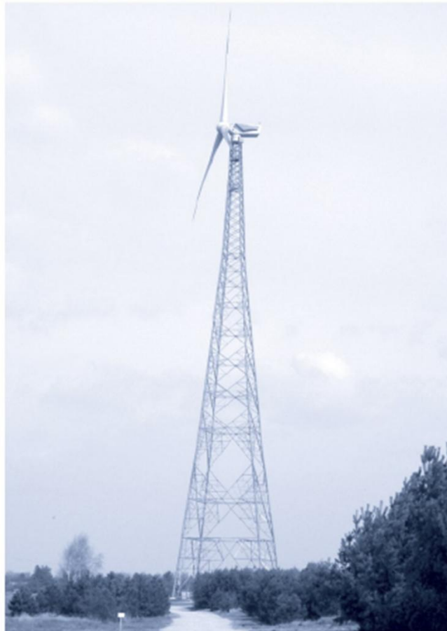
FIGURA 6.38 Turbina eólica mais alta (205 m) do planeta, a FL 2500, da empresa alemã Fuhrländer.
