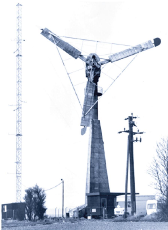
FIGURA 2.32 Turbina eólica de 200 kW instalada em Gedser, na Dinamarca. Fonte: The Danish Museum of Energy.
